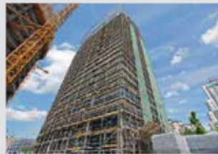
Facade Scaffold 파사드 비계
