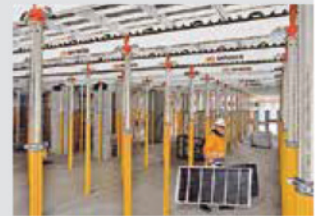
Slab Formwork 슬라브 거푸집
