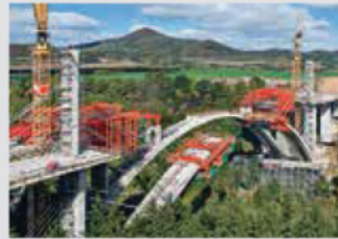
Bridge Formwork 교량 거푸집
