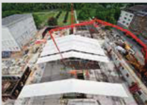
Protection Scaffold 프로텍션 비계
