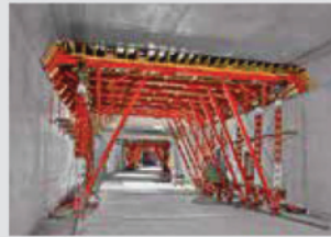
Tunnel Formwork 터널 거푸집
