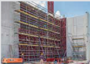
Construction Scaffold 건설 비계
