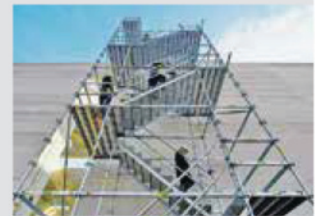
Access 작업 비계
