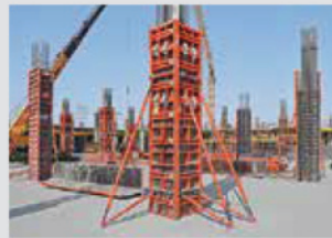
Column Formwork 기둥 거푸집
