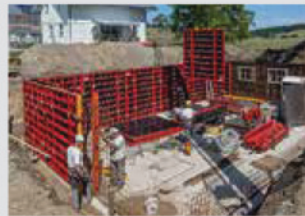
Wall Formwork 벽체 거푸집
