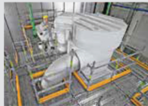
Industrial Scaffold 산업용 비계
